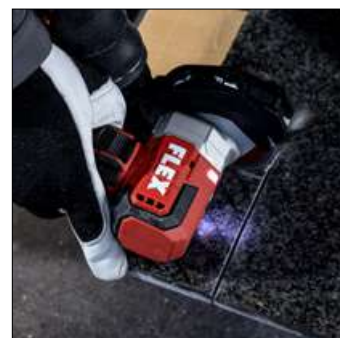
... tegels uitklinken en het ontstane stof direct afzuigen ...
